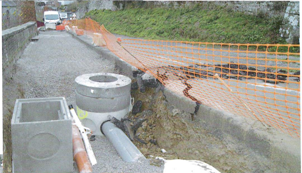
Bordures du trottoir + tampons regards et eaux pluviales
